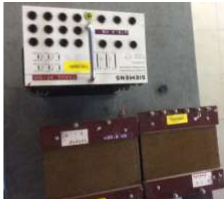
รูปที่ 8 หม้อแปลงไฟฟ้า 1 เฟส และ 3 เฟส
