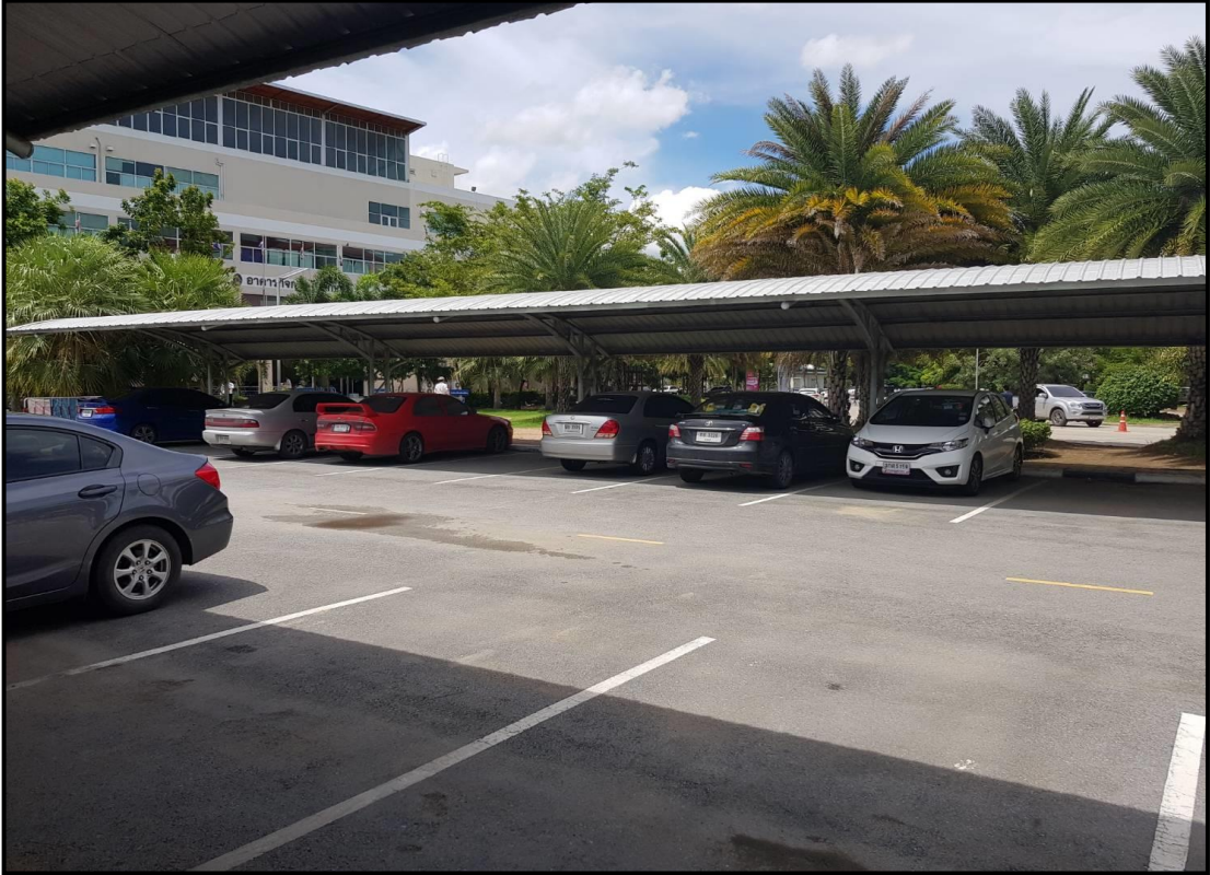
รูปที่ 57 ลานจอดรถยนต์
