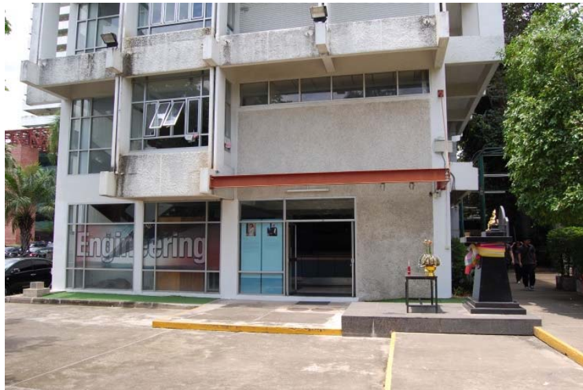
รูปที่ 5.2-3 แสดงที่ตั้งอาคารคณะวิศวกรรมศาสตร์
