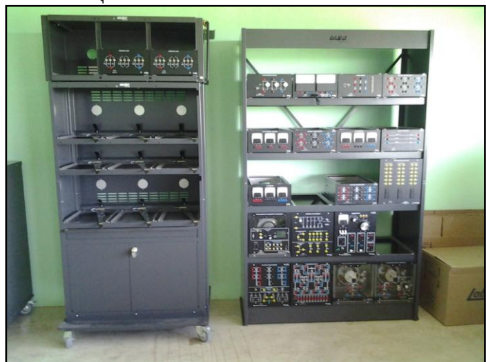
ห้องปฏิบัติการระบบส่งและจ่ายไฟฟ้ากำลัง
