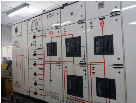
ชุดอุปกรณ์สวิตช์เกียร์และบัสบาร์ ณ อาคาร 62 ภายใต้ความร่วมมือกับภาควิชาวิศวกรรมไฟฟ้า
