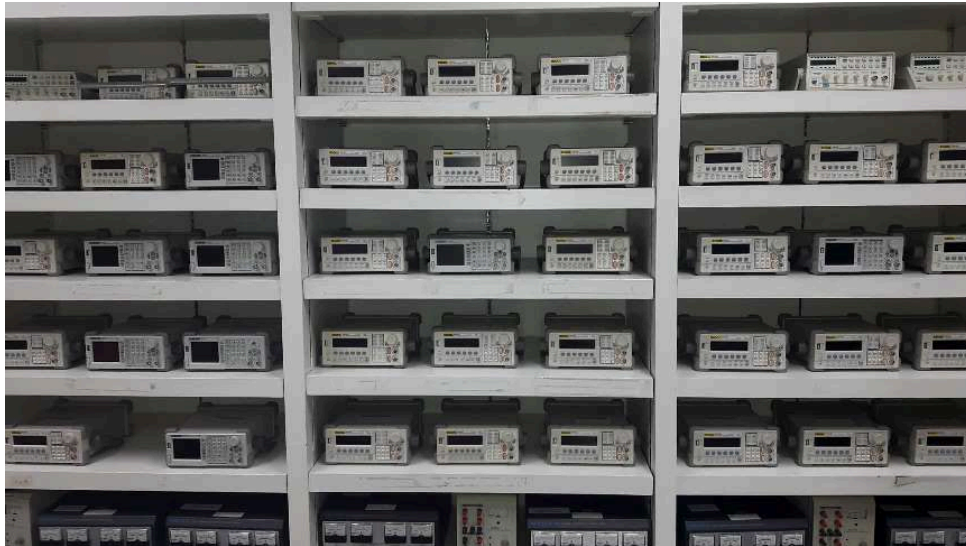
ตู้เก็บอุปกรณ์จ่ายไฟฟ้ากระแสตรงและไฟฟ้ารูปคลื่นสัญญาณ
