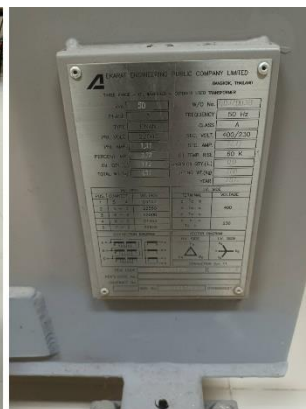
หม้อแปลงไฟฟ้าสามเฟส 50 kV, 50Hz, 22,000-400/230V
