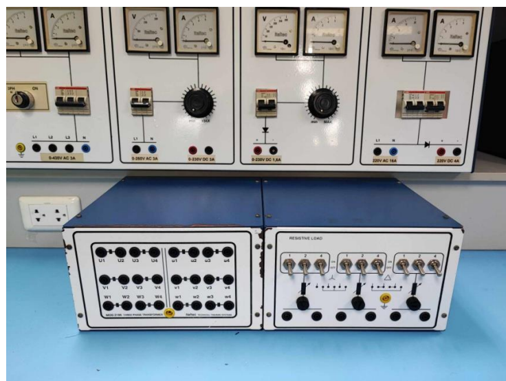
รูปที่ 36 หม้อแปลงไฟฟ้า 3 เฟส
