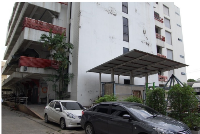
รูปที่ 5.4 อาคารปฏิบัติการพื้นฐานทางวิศวกรรม
