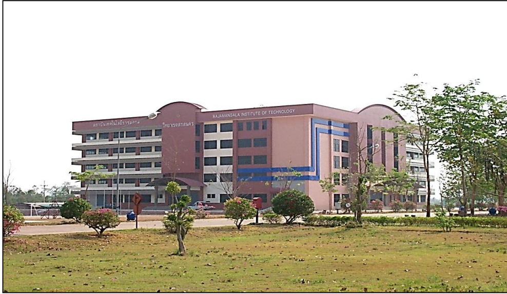
ภาพที่ 4.65 อาคารสำนักงานคณบดี คณะอุตสาหกรรมและเทคโนโลยี (สาขาวิชาวิศวกรรมอุตสาหการ)
