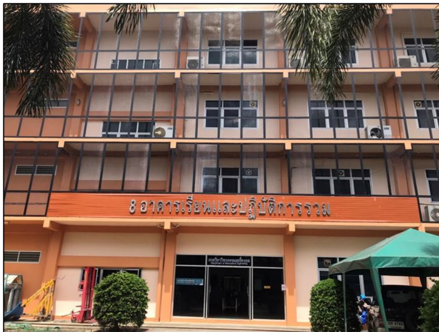
รูปที่ 4 อาคารเรียนและปฏิบัติการรวม (อาคาร 8)
