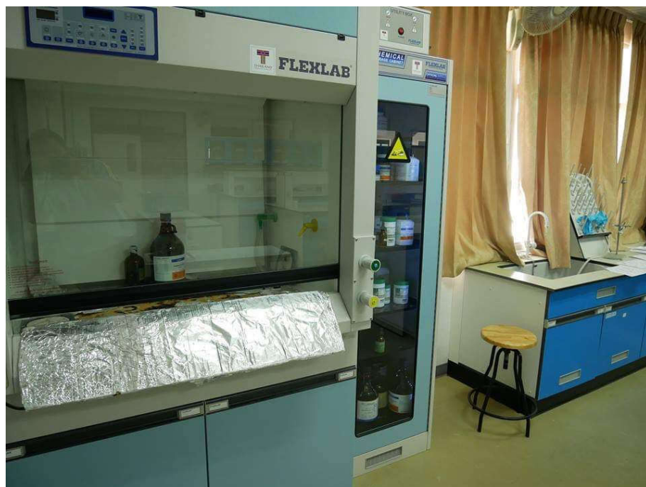
ตู้ดูดควัน/ตู้เก็บสารเคมี
