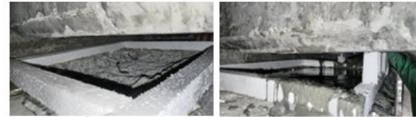
รูปที่ 11.3-3 งานเปลี่ยนแผ่นยางรองเกอร์เดอร์ จำนวน 20 แผ่น (ต่อ)
