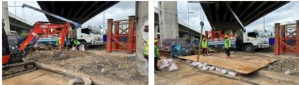
รูปที่ 11.1-1 งานจัดเตรียมพื้นที่เพื่อทำงานที่ก่อนเริ่มงานต่าง ๆ
