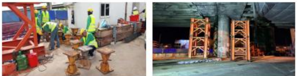
รูปที่ 11.1-3 งานจัดเตรียมชุดรองรับแบบหล่อเหล็ก (steel tower Support) (ต่อ)
