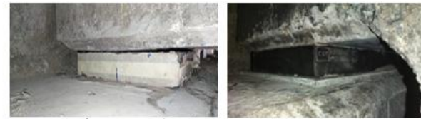
รูปที่ 11.3-4 งานเปลี่ยนแผ่นยางรองเกอร์เดอร์ จำนวน 20 แผ่น (ต่อ)
