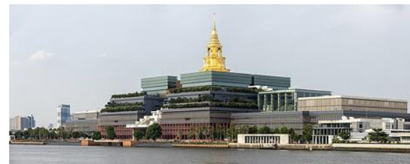
รูปที่ 4-1 ลักษณะอาคารและพื้นที่ของสภายะสภาสถาน
