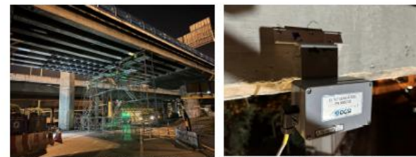
รูปที่ 4-1 การติดตั้งนั่งร้านเพื่อใช้ฐานเพื่อรองรับอุปกรณ์วัดแบบปกติ โดยในรูปแสดงให้เห็นอาคาร ซึ่งถูกติดตั้งไว้กับเกอร์เตอร์โดยไม่เห็นถึงทางสัญจรได้สะพานที่ต้องเปิดให้รถวิ่งปกติ จำเป็นต้องมีฐานรองรับเหมือนอุปกรณ์วัดปกติ
