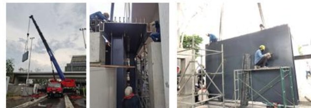
รูปที่ 16-6 การยกบานประตูเหล็กเพื่อติดตั้งหน้างานซึ่ง ณ มุมนี้จะเป็นถึงขนาดและอุปสรรคในการติดตั้ง อีกทั้งยังพบรูปแบบในการทำให้ประตูทั้งสองบานเหลื่อมกันดังที่ได้อธิบายไปแล้วก่อนหน้านี้
