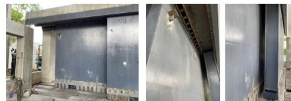
รูปที่ 16-7 การเข้ารูปช่องประตู ฐานเหล็กคานบน และการเก็บงานสำหรับบัวที่วางเหล็กคานล่าง
