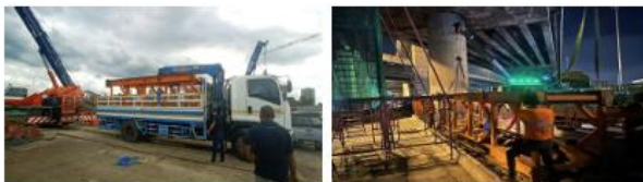
รูปที่ 11.1-2 งานจัดเตรียมชุดรองรับแบบหล่อเหล็กพร้อมติดตั้งในตำแหน่งที่กำหนด
