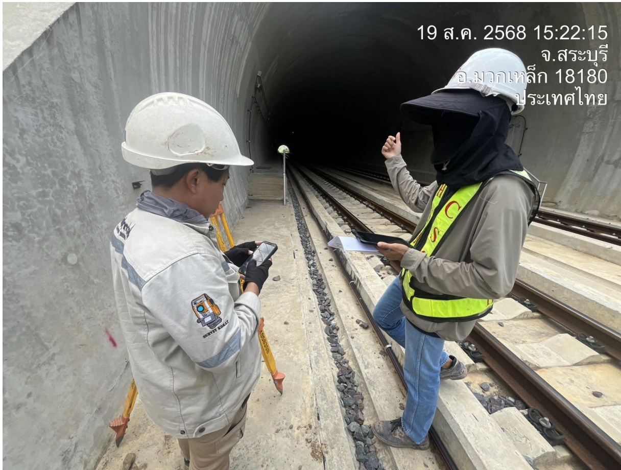
การตรวจวัดโดย Total Station
