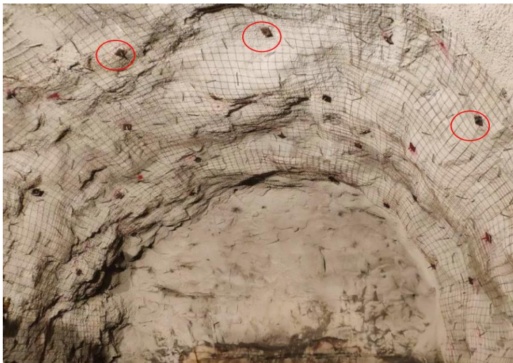
การติดตั้ง Rock Bolts
