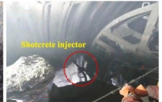
(d) Steel fiber shotcrete spraying
