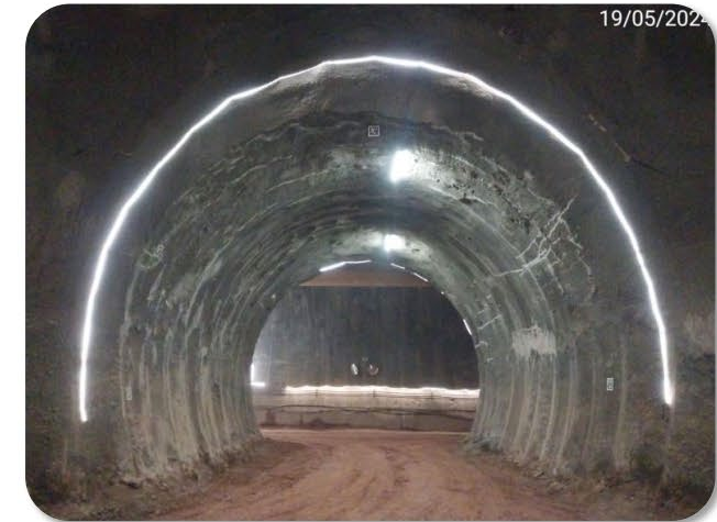
ห้องเครื่อง (Equipment Room)
