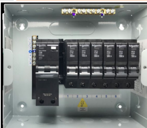
ตัวอย่างคอนซูมเมอร์ยูนิตแบบ plug-on
