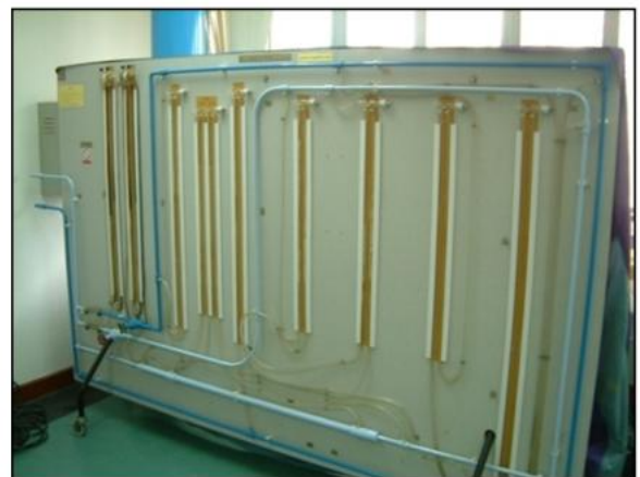
ชุดทดสอบ Multi Pumps Test
