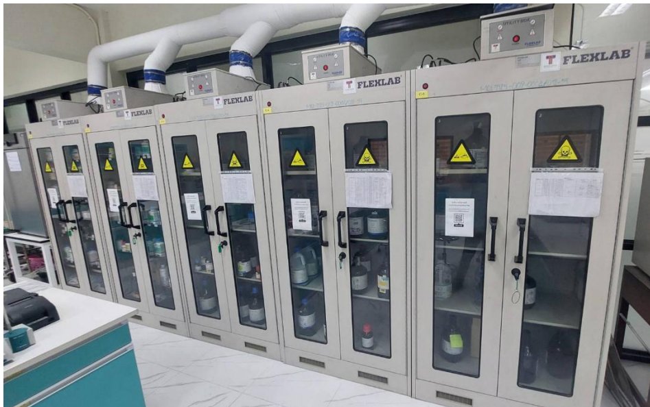
รูปที่ 16 ตู้เก็บสารเคมี ขนาด 0.58x1.00x2.00 เมตร ยี่ห้อ FLEXLAB รุ่น CB1/SS
