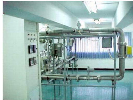
รูปที่ 72 หน่วยทดลองการควบคุมอัตราการไหล
