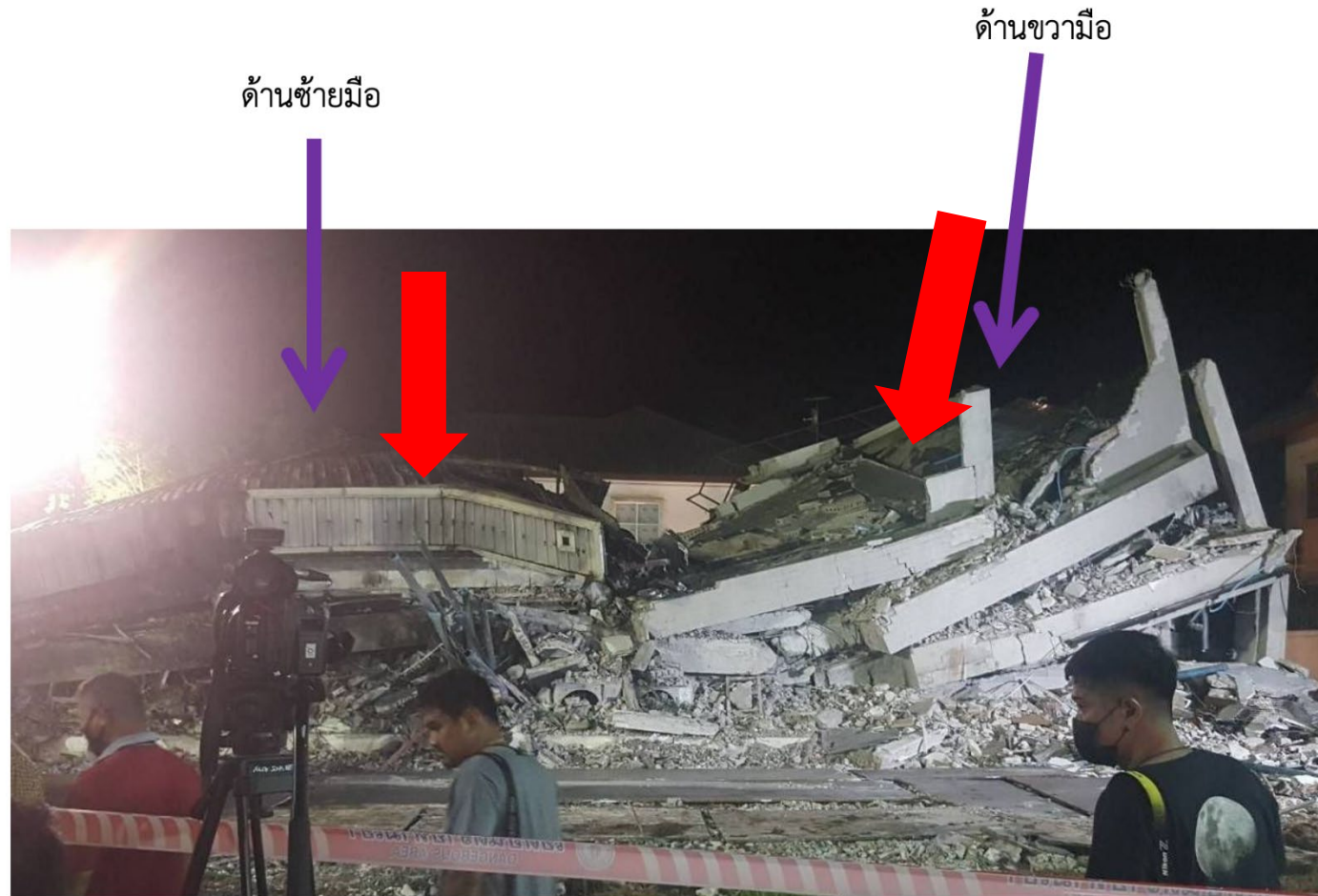
รูปที่ 3 ด้านซ้ายมือมีลักษณะการกองของชิ้นส่วนโครงสร้างเป็นแนวระนาบ และมีจุดศูนย์กลางมวล (Center of mass) อยู่ต่ำกว่าด้านขวามือ
