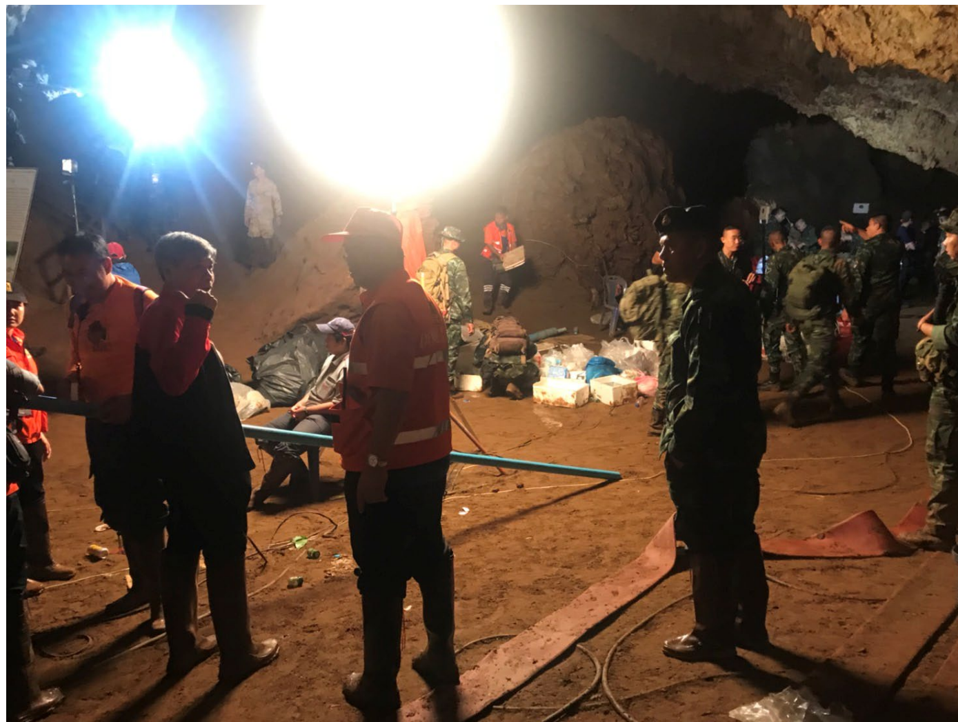
ติดตั้ง Pole วัดระดับน้ำไว้ที่ปากถ้ำ
