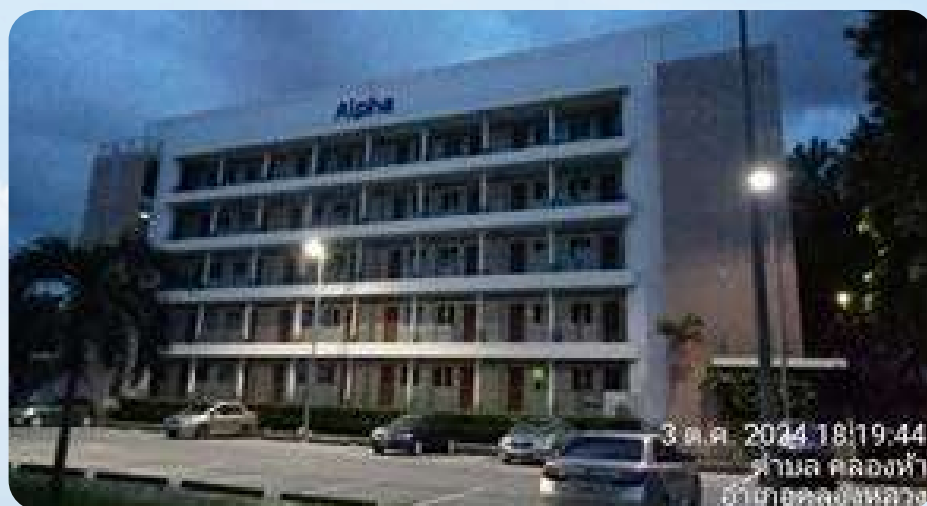
Solar Rooftop ไฟฟ้าส่องสว่างถนน
